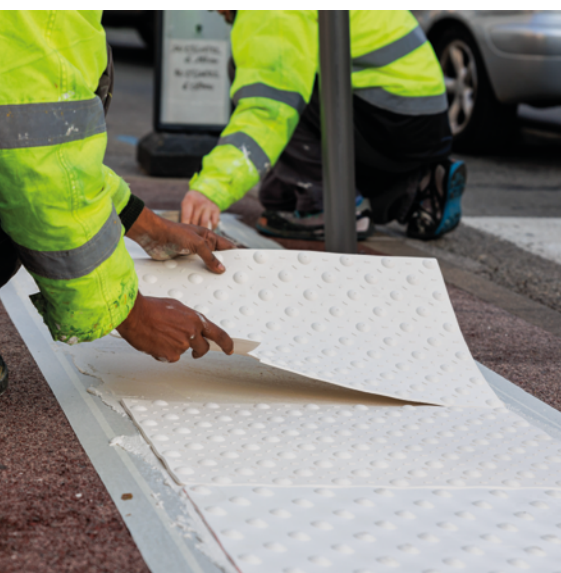
Pose de bandes podotactiles
