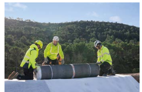
L'écrêteur de crue de l'Aspe lors d'une des dernières phases de travaux : la pose de la géomembrane.
